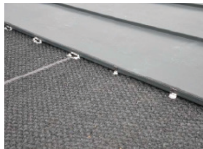
Przykład zastosowania folii dachowej METALDREN 450 g pod pokrycie dachowe KJG FALZ.
